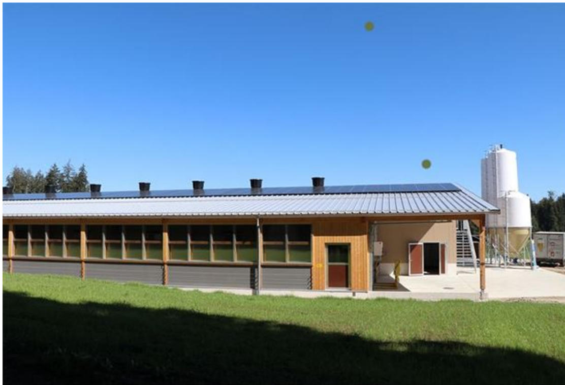
Die Fotovoltaik-Anlage auf dem Dach führt zu einem Energieüberschuss, der auf dem Betrieb genutzt wird (Bildquelle: Ann Schärer)
